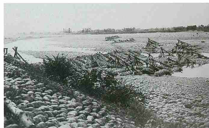
六ヶ用水取入堰 (昭和11年)
