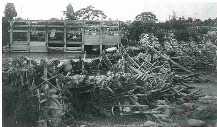
若林口用水取入堰（昭和11年）
