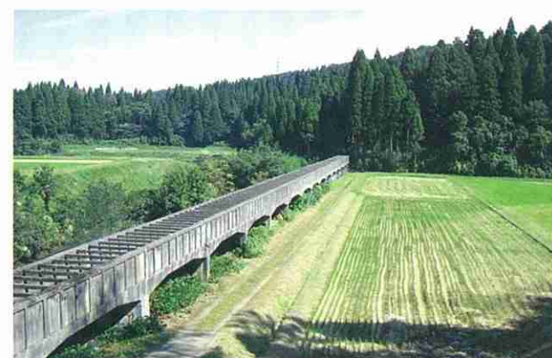
梅ノ木水路橋（射水市梅木地内）
