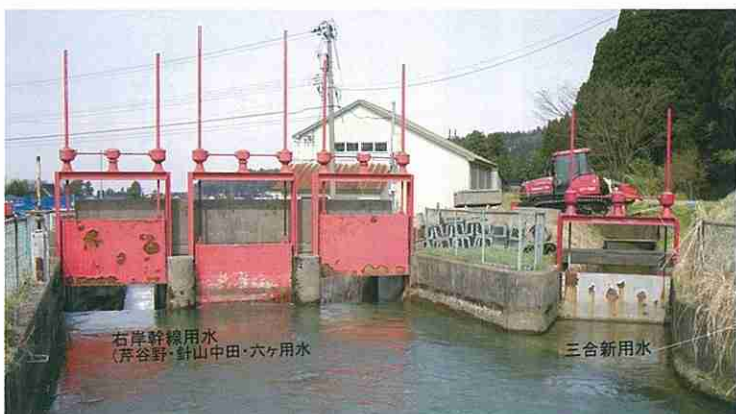
三合新用水分水場（左：右岸幹線用水、右：三合新用水）
