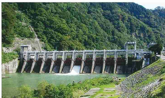
完成した庄川用水合口堰堤
