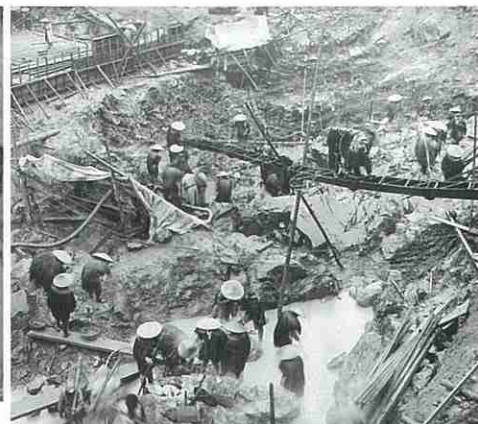
左岸基礎岩盤（昭和12年2月）
