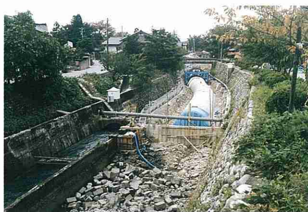
共同用水路の管路工事（砺波市庄川町金屋地内）
