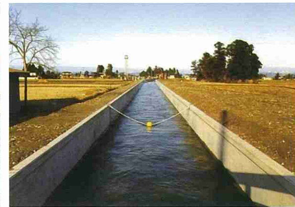
改修（昭和50～平成11年）後の二万石用水路
