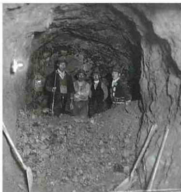
右岸幹線隧道工事（昭和15年3月）
