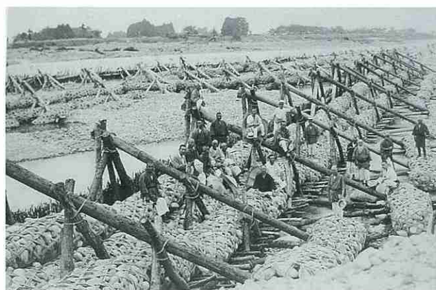
聖牛と蛇籠を配した導水堰（千保柳瀬合口用水、昭和11年）
