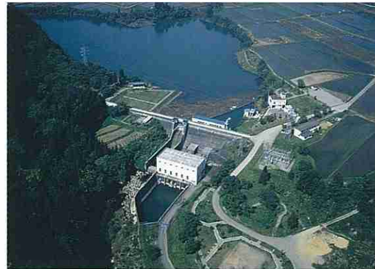
和田川庄東第2発電所
