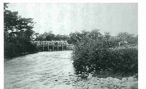
鷹栖口用水取入口（昭和11年）
