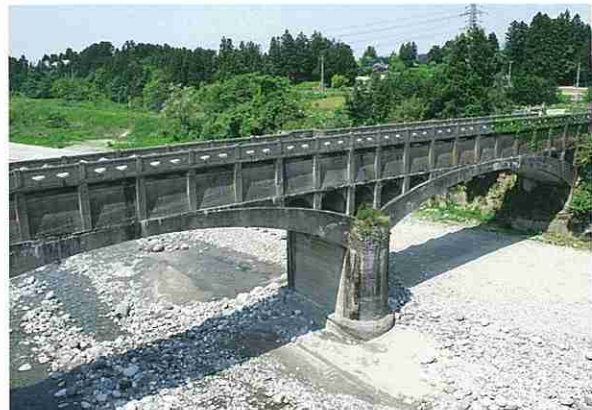
昭和27年築造後の水路橋（立山町岩崎寺地内）
