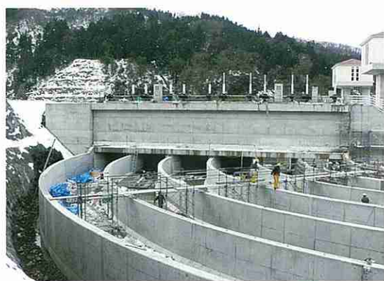
工事中の沈砂池（平成19年3月）
