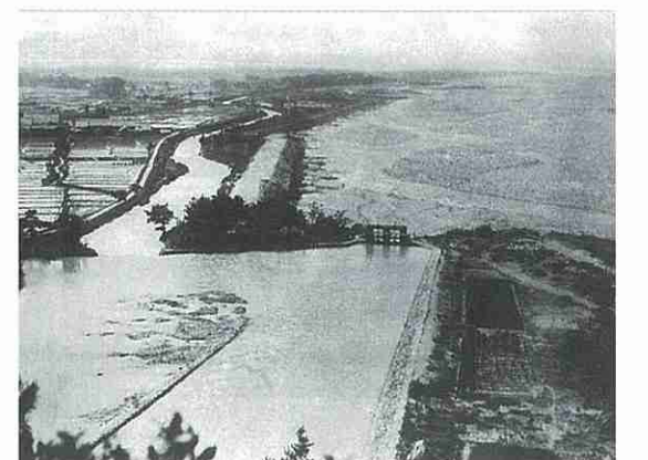
完成した常西合口用水（上滝砂溜、明治26年）
