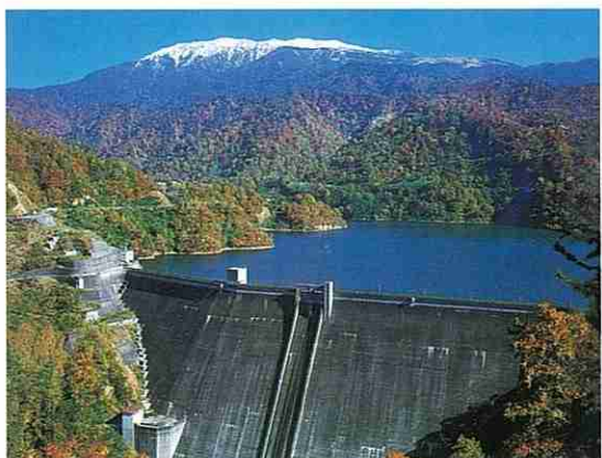
有峰ダム（昭和35年完成、『常西合口百年史』より）
