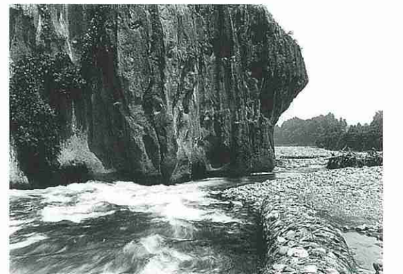
第1隧道前取水口（鷹泊、明治25年）
