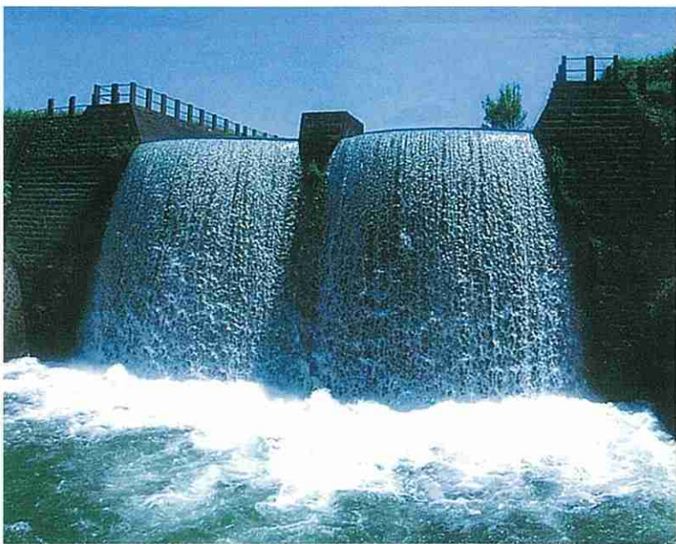
昭和27年築造の常願寺川沿岸共通幹線水路大落差工（落差約12メートル、立山町横江野開地内）
