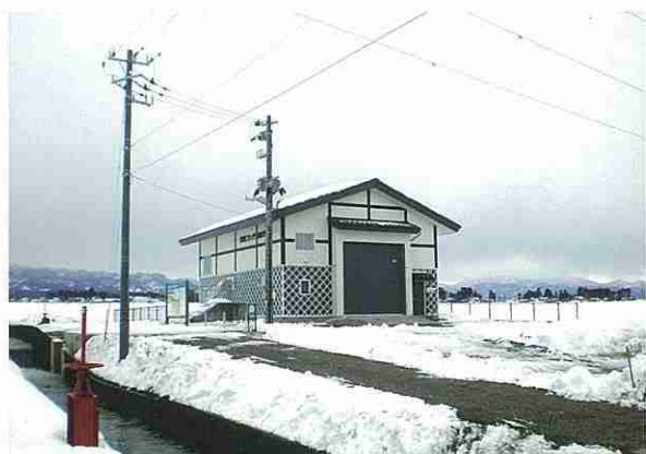
仁右エ門用水発電所(立山町東大森地内、平成21年12月完成)
