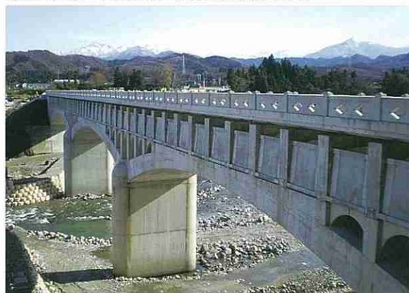
現在の左岸連絡水路橋（立山町岩峠寺地内）
