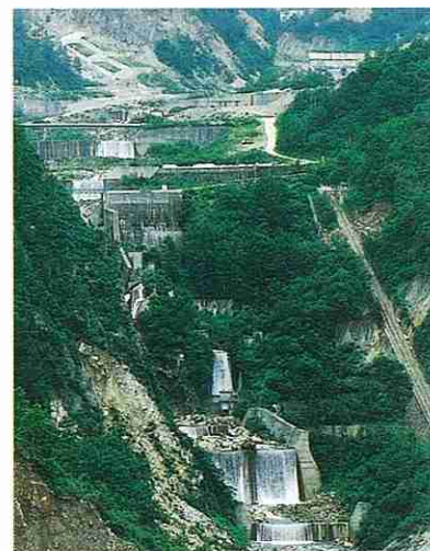
白岩砂防堰堤（昭和14年完成）
