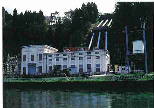
上滝発電所（富山市中滝地内、大正13年完成）
