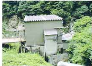
北陸電力株長棟川第二発電所（昭和3年運用開始）
