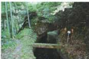
②仏谷付近の改良前(上) 改良後(下)
