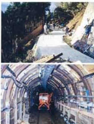
県営かんがい排水事業施工の様子
