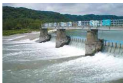
① 羽村取水堰 羽村取水堰は固定堰と投渡堰と呼ばれる珍しい堰でできている。投渡堰は、松丸太や木の枝、砂利などで塞がれ、洪水の時は堰を取り払うことができる。
