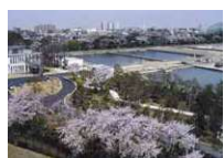
⑧ 境浄水場 境浄水場は、大正13(1924)年から稼働している縦連ろ過方式の浄水場である。原水は、玉川上水と同じ羽村堰で取水し、村山山口野水池に貯めて、導水している。
