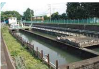
③ 小平監視所 水温原水は、小平監視所から2300mmから2000mmまでの太さの導水管によって東村山浄水場へ送られている。
