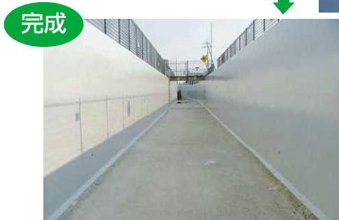
■水路の補強状況
