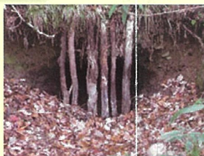
人首隧道入口
