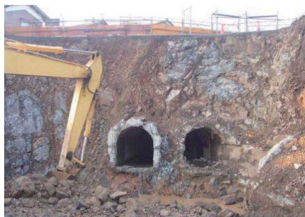
酒生隧道（施工時の入口付近）
