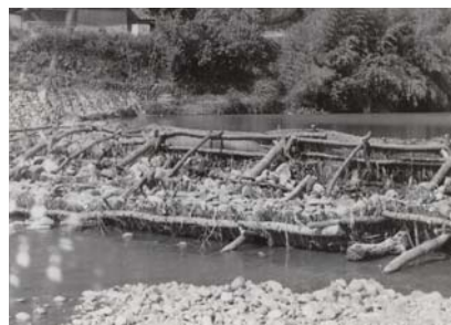
昭和 38 年以前の酒生用水の取水堰
