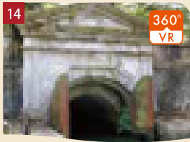
第1トンネル入口
