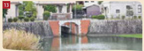
第2疏水取水口と洞門
