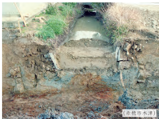
(上水道の導水路)
