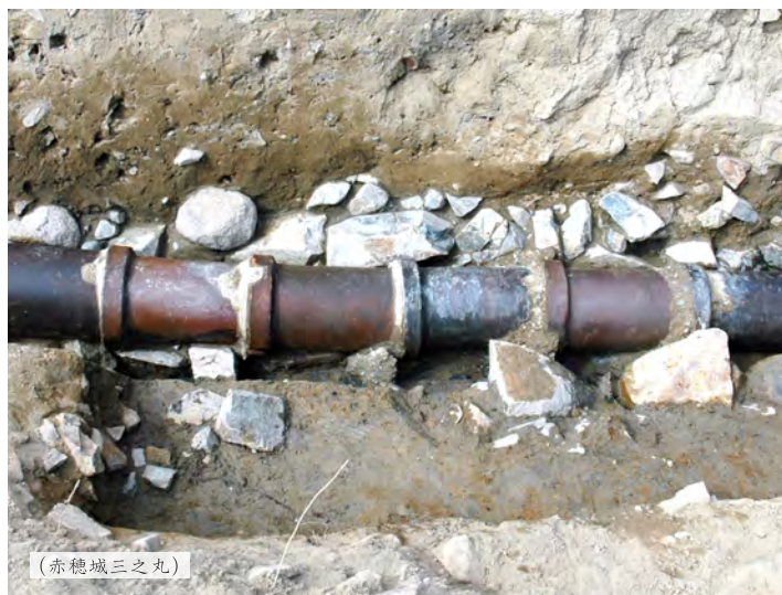
本焼土管：釉薬をかけて水漏がおこらないようにした土管
